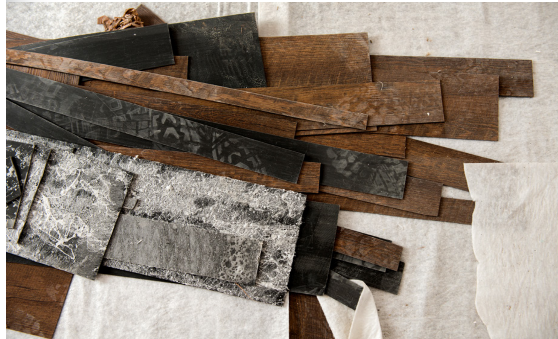
Baustelle Lenggen · 13. Januar 2017 Abschnitte des Vinyl-Bodenbelags
