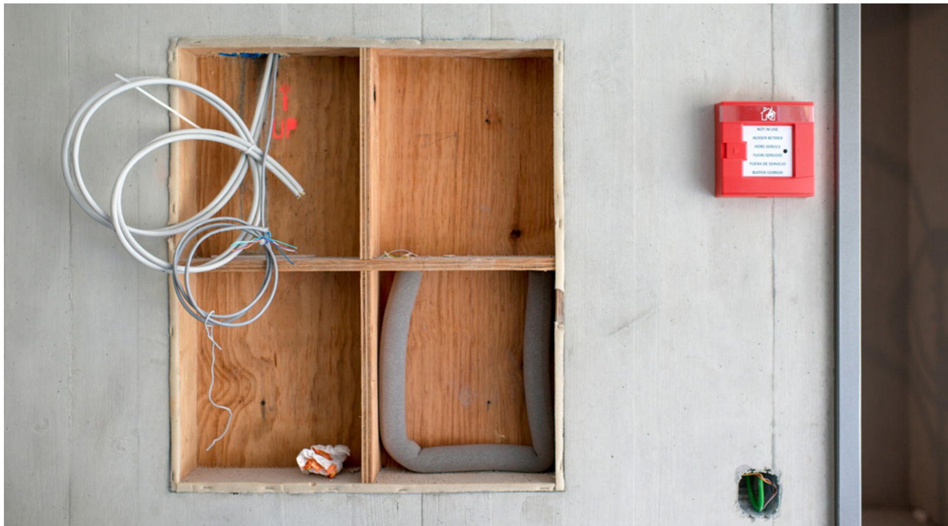
Baustelle Lenggen · 3. November 2016 Aussparung für das Bedienungstableau der Brandmeldeanlage im 1. OG dahlia
