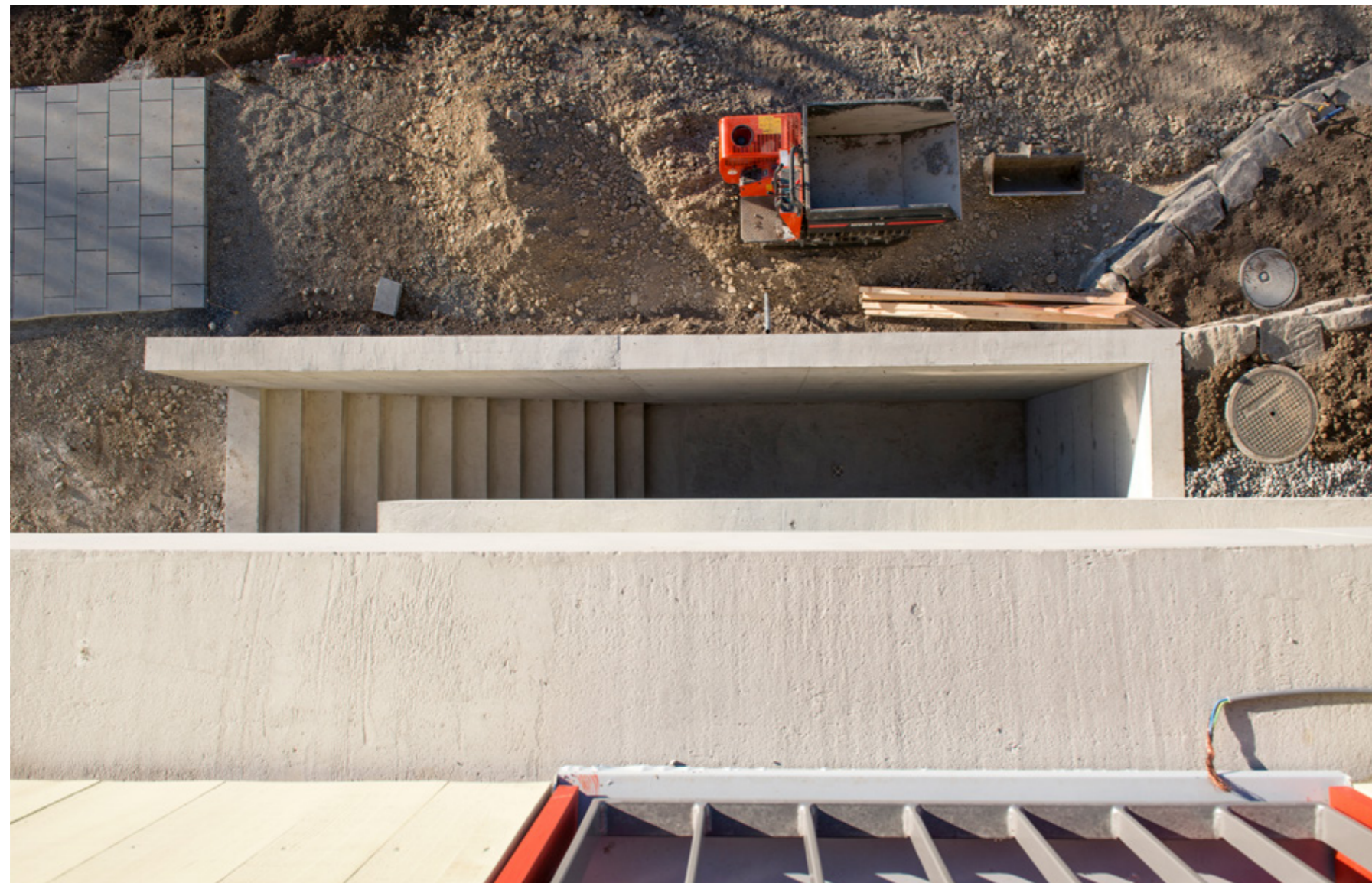
Baustelle Lenggen · 8. Dezember 2016 Die Treppe zum Untergeschoss des dahlia-Gebäudes
