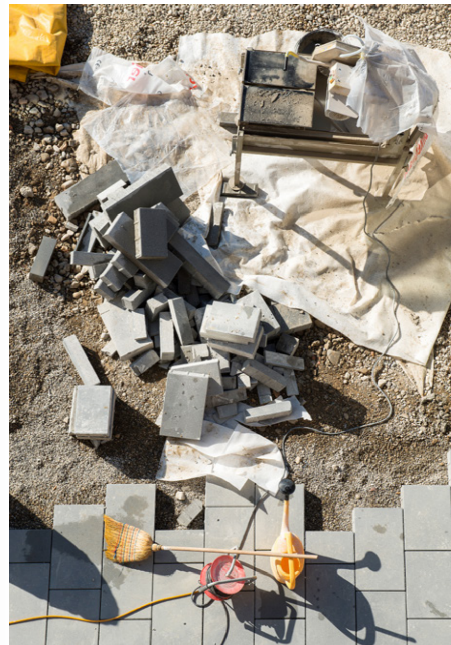
Baustelle Lenggen · 15. Februar 2017 Sickersteine (La Senza Öko) in den Formaten 195 x 295 x 80 / 395 x 295 x 80 / 495 x 295 x 80
