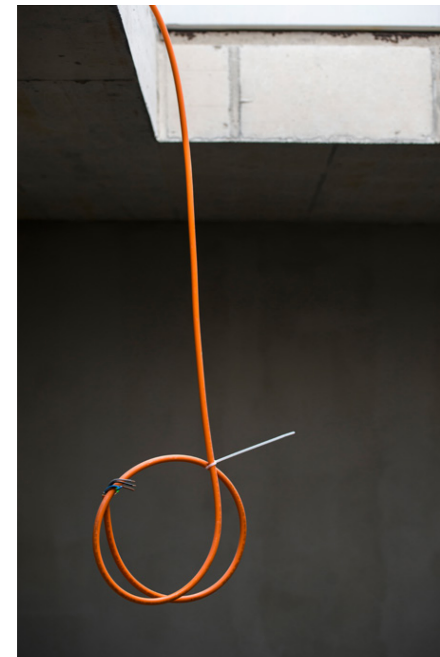
Baustelle Lenggen · 3. November 2016 Anschlussleitung für die Rauch-Wärme-Abzugsklappe
