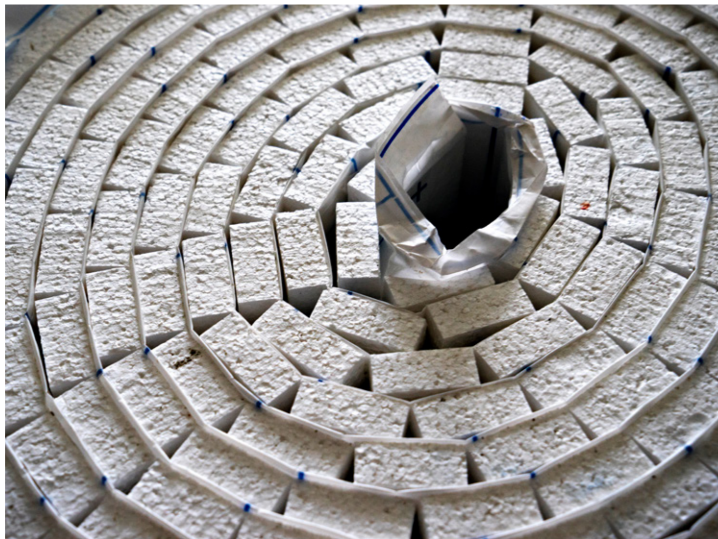
Baustelle Lenggen - 22. April 2016 Trittschalldämmung Roll EPS-T 22/20 (verlegt unter dem Unterlagsboden)
